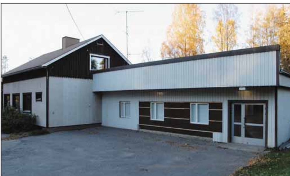
Kettusen vanhaan kauppakiinteistöön Kartanontie 20:een saneerataan parhaillaan tiloja uutta hoivakotia varten. Toiminta käynnistyy ensi vuoden alussa.
